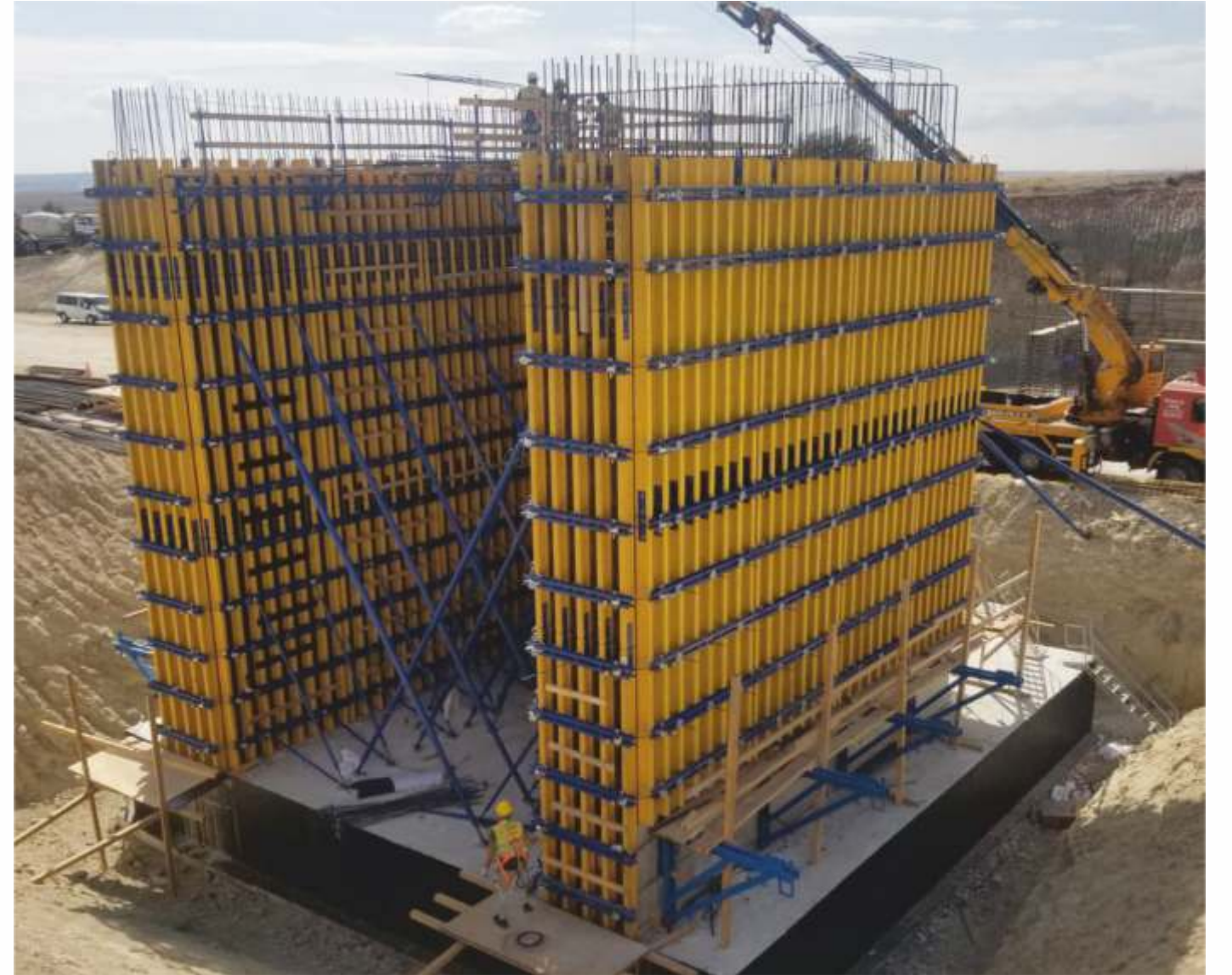
Portiwood kuşak birleştirme elemanı ve kaması ile daha geniş paneller elde edilebilir. Wider panels can be obtained with the Portiwood waler and wedge.
